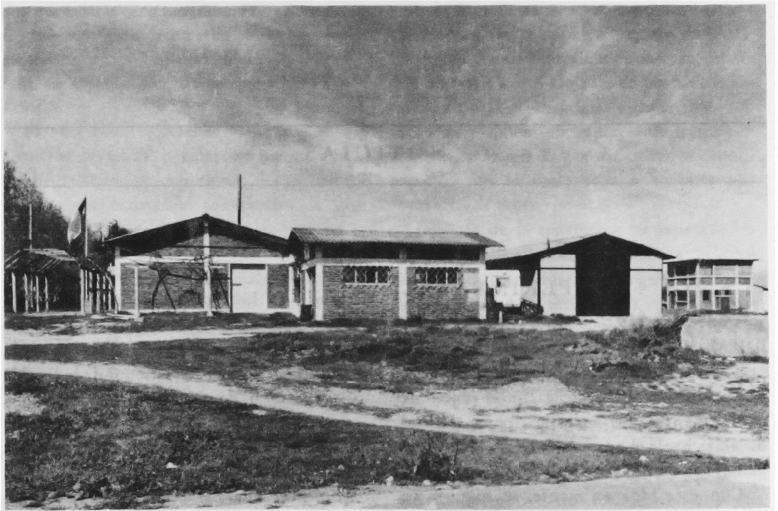
Fig. 1. Vista de los edificios de estudios de cemento, de molienda, bodega y laboratorio de radiación cósmica.
