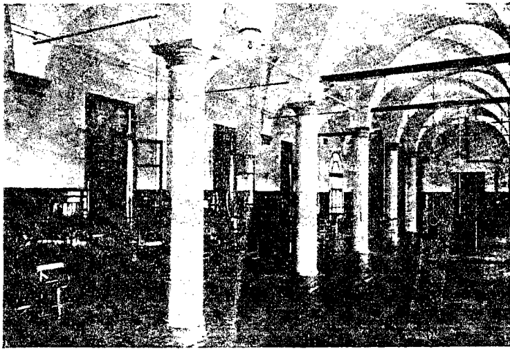
Núms. 21 i 22.—Instituto Rizzoli. Salas de gimnástica mecánica suca.
