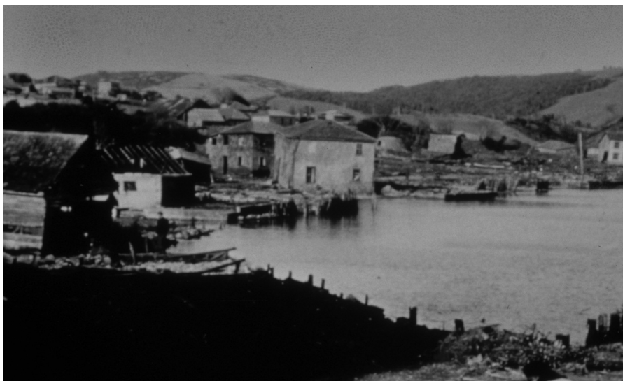
Figura 3. Ancud. Subsidencia y daño del tsunami (ola de 15 metros).
