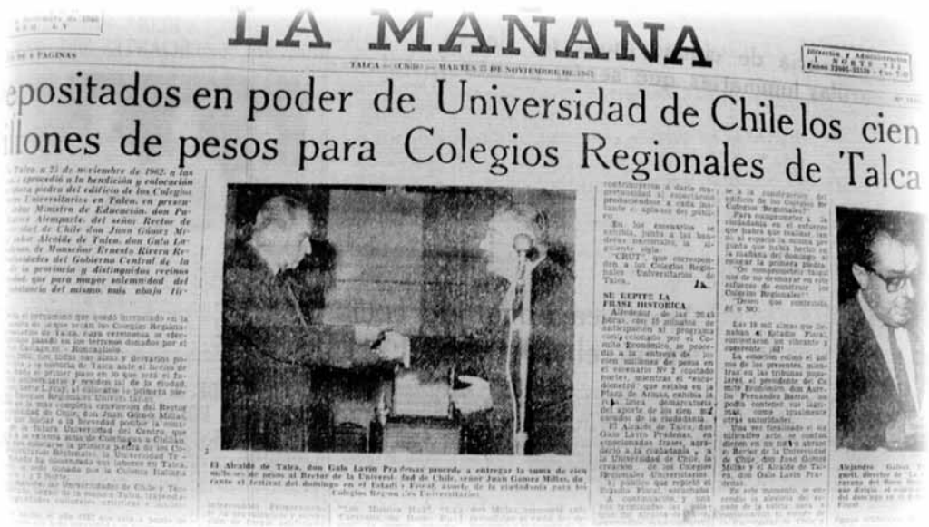
Colocación de la Primera piedra de los Colegios regionales en Talca, 25 noviembre 1962.
